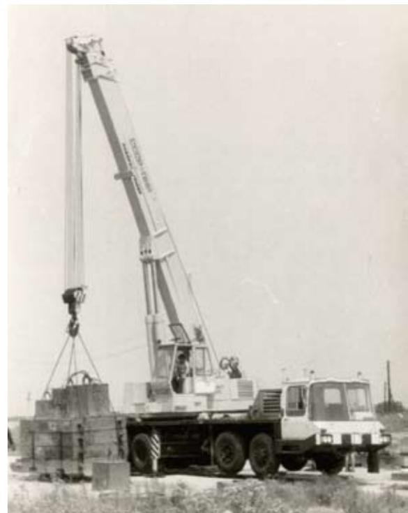
Статические испытания 40-тонного крана КС-6471
