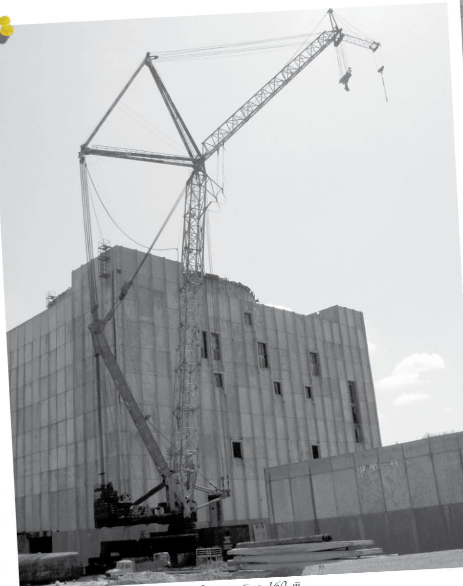
Рельсовый кран СКР-3500 грузоподъемностью 160 т
