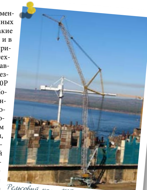
Рельсовый кран СКР-3500ЭМ грузоподъемностью 100 т
