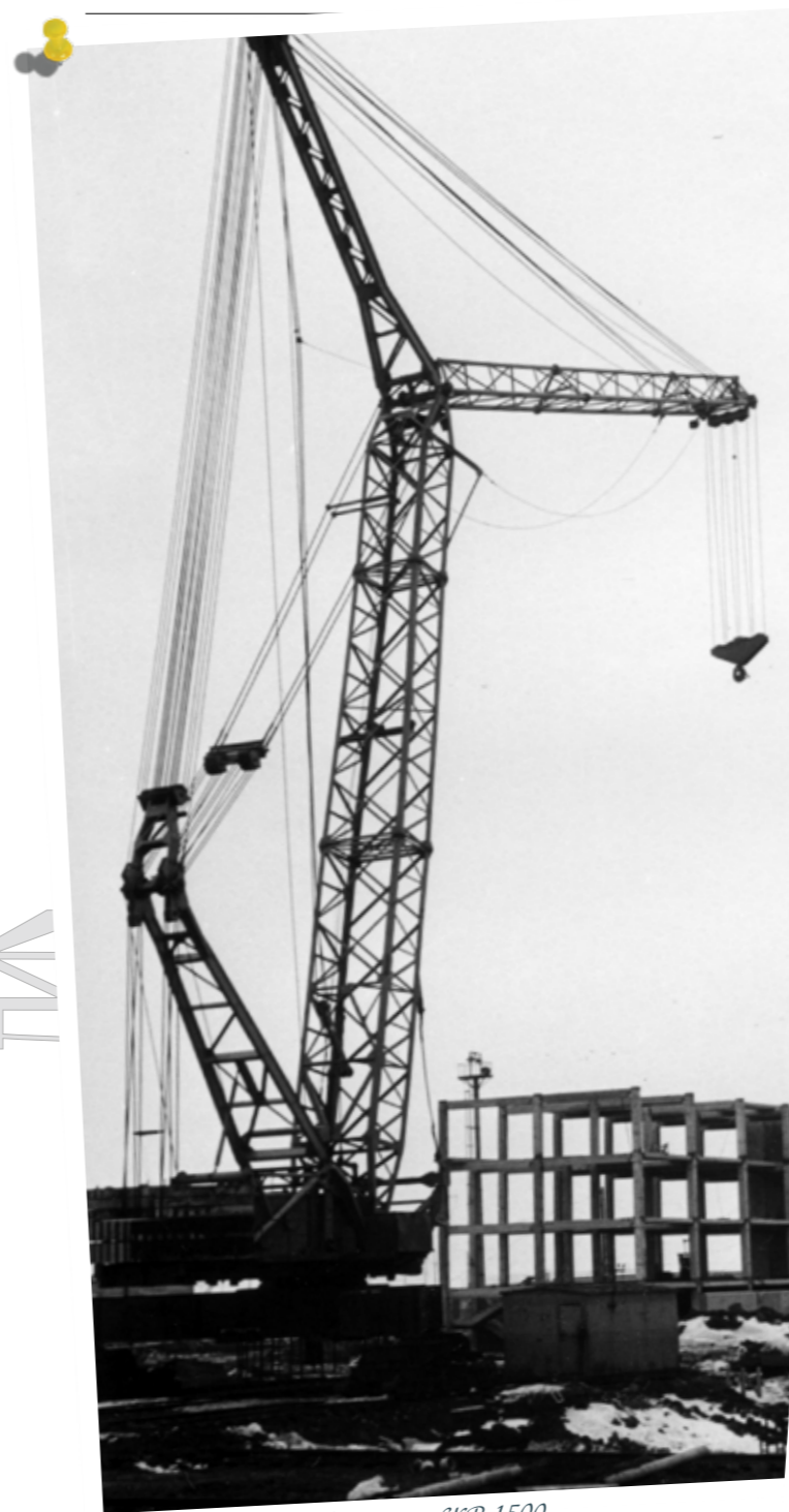
Монтажный рельсовый кран СКР-1500 грузоподъемностью 60 т
