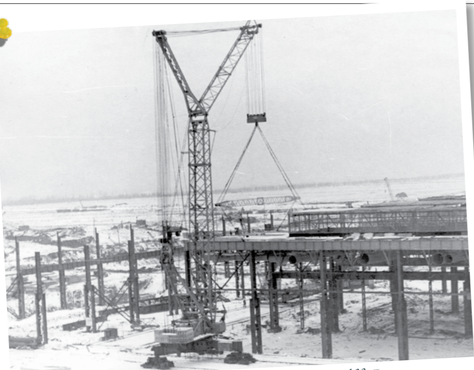
Модернизированный рельсовый кран СКР-1500 грузоподъемностью 100 т
